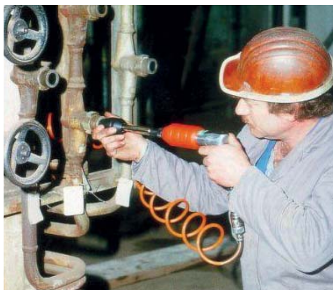
Шлифование при помощи станка KVS на месте
