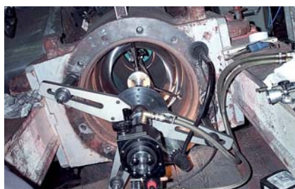
Шлифование на месте при помощи станка HTS 400
