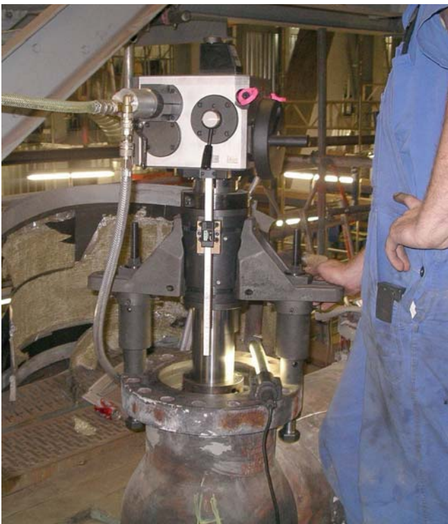
Применение станка MD на месте установки предохранительной арматуры
